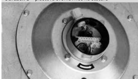
Obrázek 8 – plastová svorkovnice na statoru
