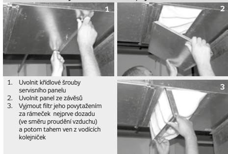
Obrázek 59 – výměna filtrační kapsy
