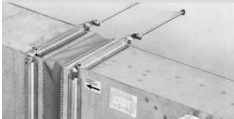
Obrázek 13 – ukotvení ventilátoru
