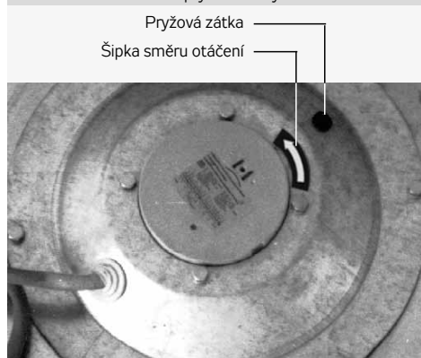
Obrázek 12 – umístění pryžové zátky
