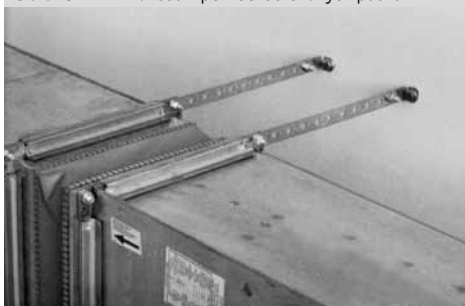
Obrázek 14 – zavěšení pomocí děrovaných pásek
